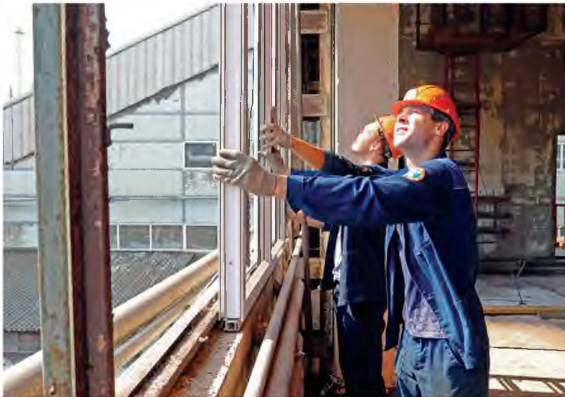
Изготовлением деревянных опор под трубопроводы, новых дверей, окон, лавочек и прочих деревянных конструкций занимается участок по изготовлению и установке столярных изделий
