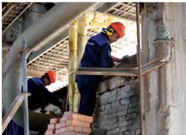
Без строителей на предприятии не обходится ремонт на производстве и в других подразделениях
