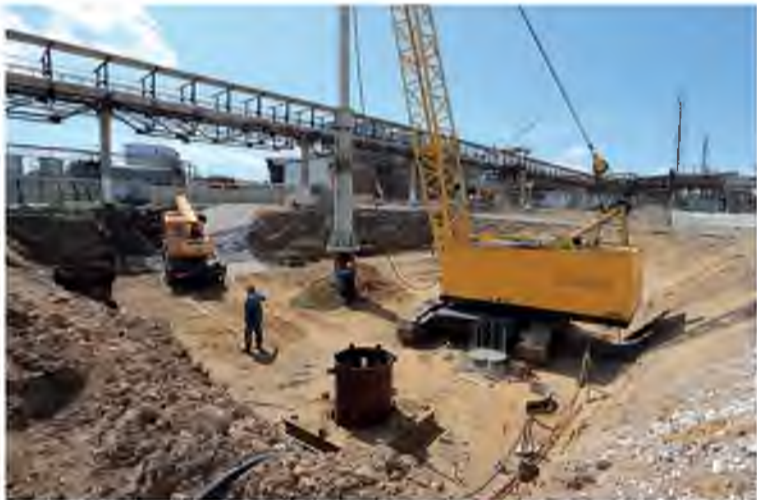
159 работников подрядной организации и 16 единиц тяжелой техники работают на стройплощадке третьего агрегата карбамида
